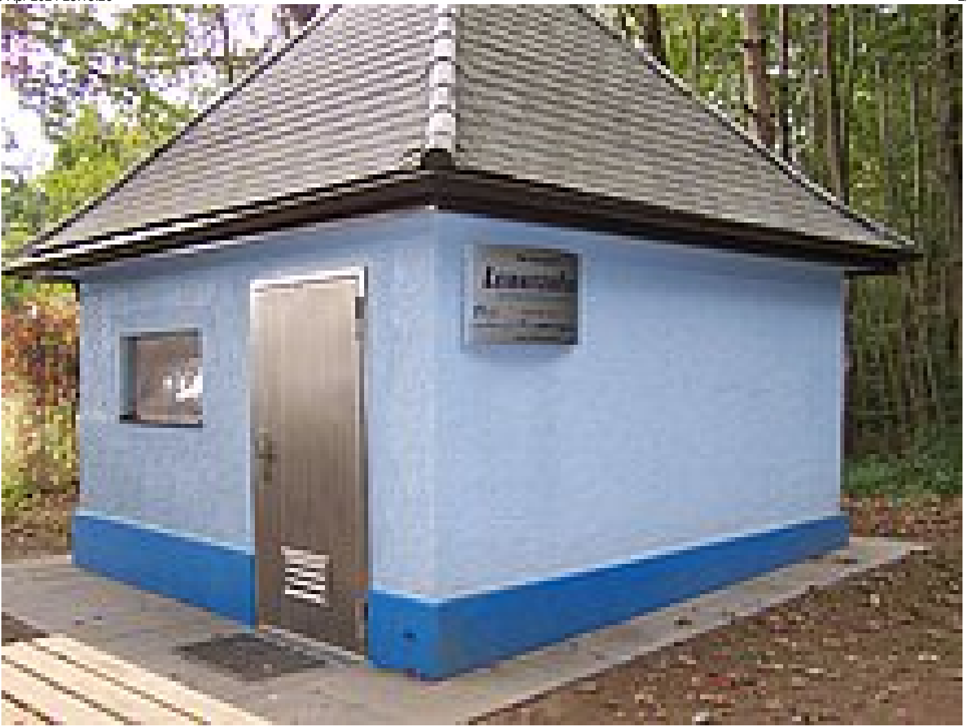
Leibnitzerfeld Wasserversorgung GmbH - pumping station Kaindorf 1
