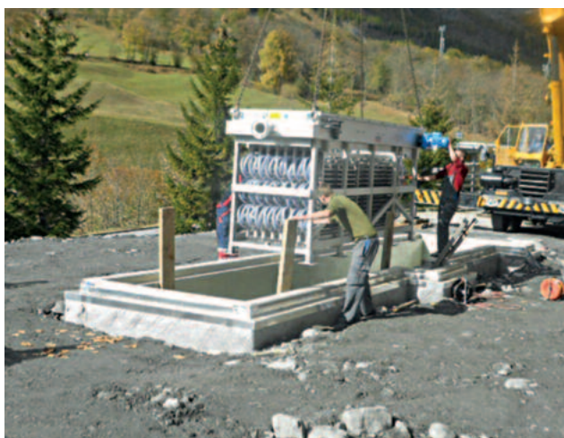
Avloppsvatten från en simhall, uttag av värme ca 450 kW, använt för uppvärmning av simhallen
