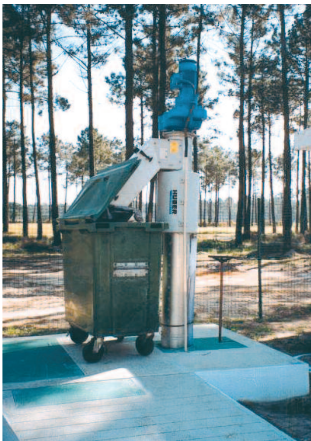
Oberirdische Entsorgung des entwässerten Siebgutes einer HUBER Schachtsiebanlage ROTAMAT® RoK4.
