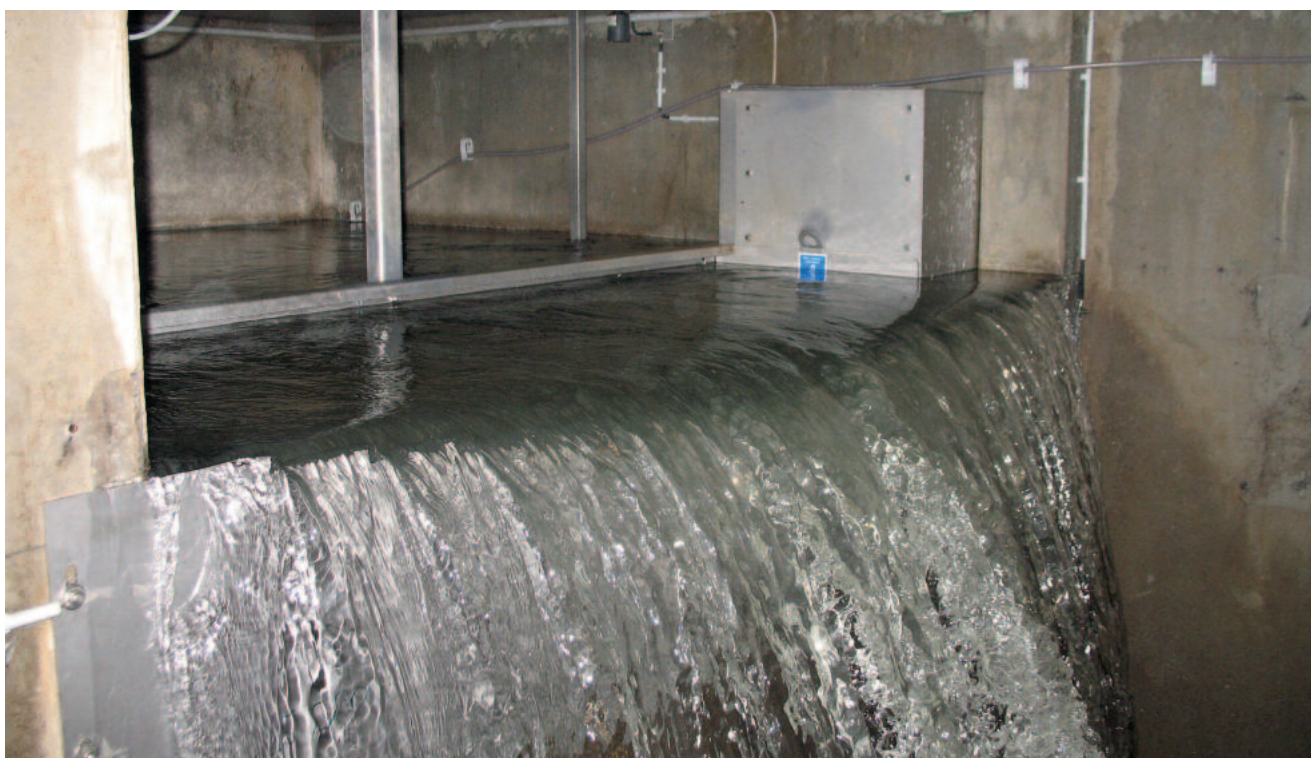
HUBER Siebanlage ROTAMAT® RoK2 mit nachliegender Entlastungsmengenmessung während eines Entlastungsereignisses.
